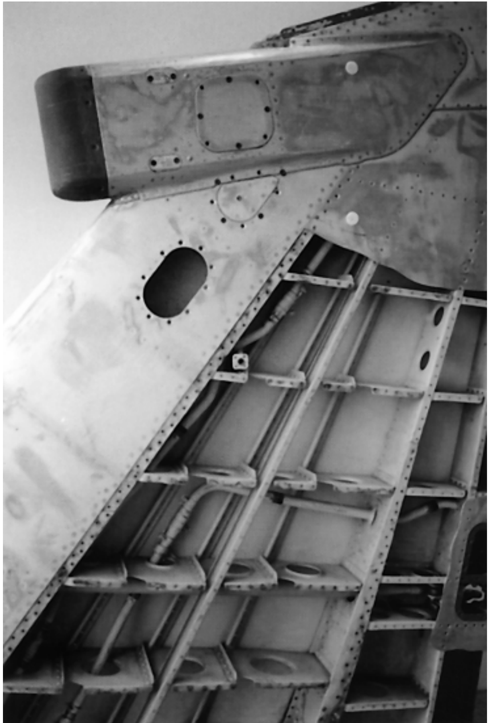
Fig 6-4 Harrier Fin Construction
